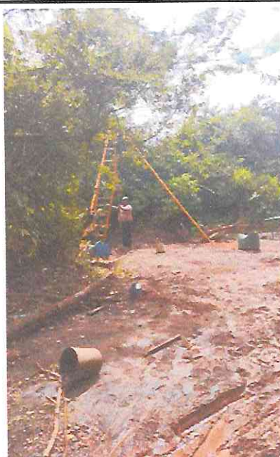
Descrição do serviço: SONDAGEM NA PONTE 2 - LOBO LEITE SPT - 03
