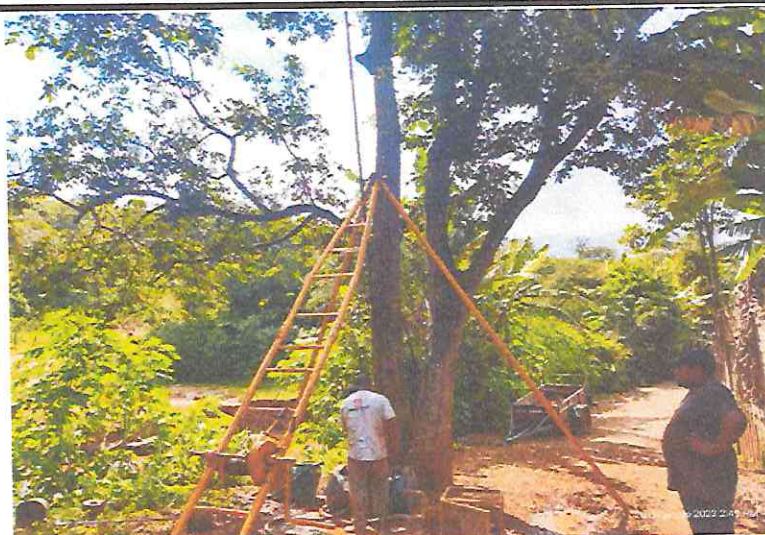
Descrição do serviço: SONDAGEM NA PONTE 1 - LOBO LEITE SPT - 01
