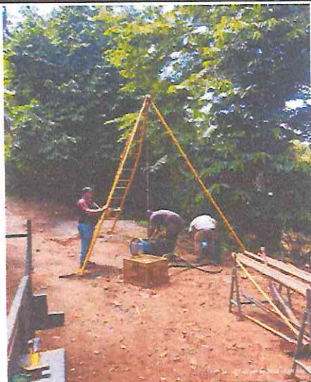
Descrição do serviço: SONDAGEM NA PONTE 1 - LOBO LEITE SPT - 02
