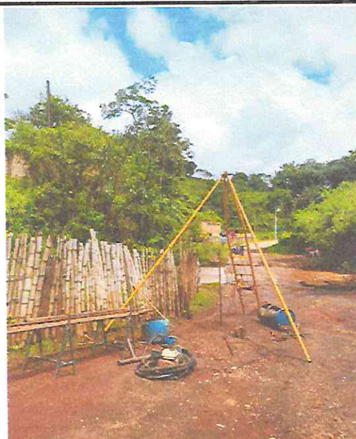
Descrição do serviço: SONDAGEM NA PONTE 2 - LOBO LEITE SPT - 04
